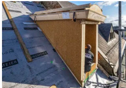
LITEC Gaubenbausysteme Bausätze – mit und ohne integrierte Schalldämmplatte erhältlich (GBS I GBS M) (© Oliver Heint)
