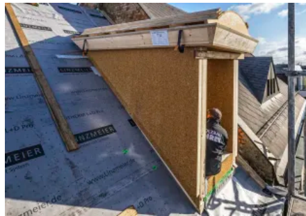
LITEC Gaubenbausysteme Bausätze – mit und ohne integrierte Schalldämmplatte erhältlich (GBS I GBS M) (© Oliver Heinel)
