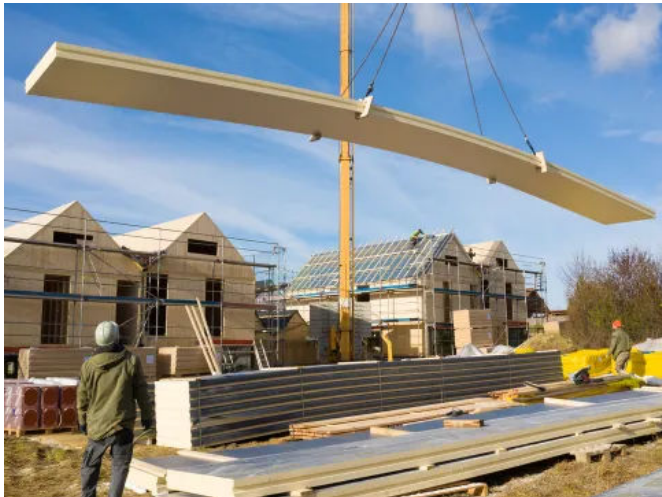
PAL XXL ein flexibles und zeitsparendes Dämmsystem im Großformat
