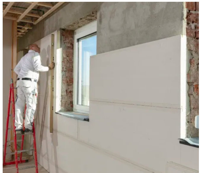
LINITHERM® PAL SIL, Dämmung der Außenwand von innen
