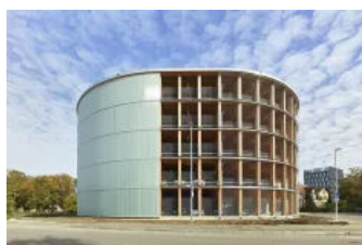
Holzparkhaus Wendlingen - Parkhäuser (© Roland Halbe)
