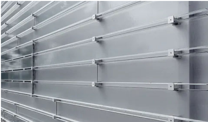
DO@55 Stadtkrone Ost D-Dortmund - LINIT®EcoGlass P 26/60/7, 504, TH (thermisch vorgespannt, Heat-Soak-Test)
