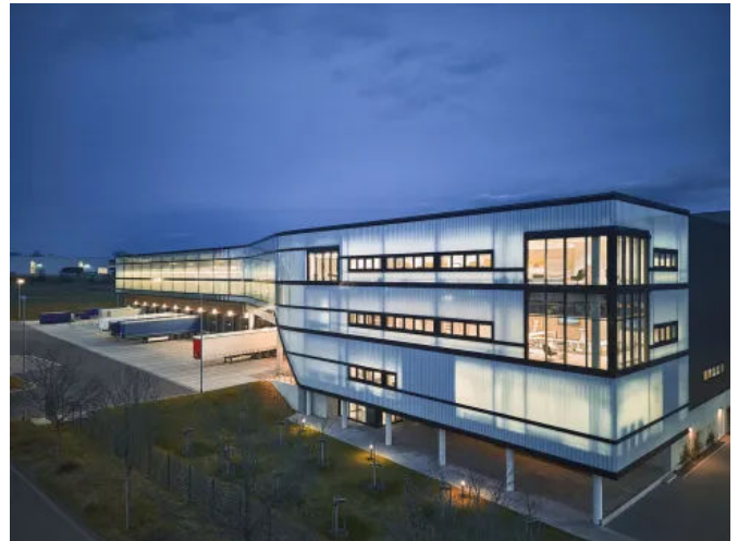
Weidmüller - Next Generation Logistics - Eisenach - LINIT®EcoGlass P 23/60/7, clarissimo, teilweise TH(thermische vorgespannt, Heat-Soak-Test), in Kombination mit transluzenter Wärmedämmung (TWD); LINIT®EcoGlass P 26/60/7, clarissimo, W1.7, teilweise TH, in Kombination mit transluzenter Wärmedämmung (TWD) (© Albrecht Voss)
