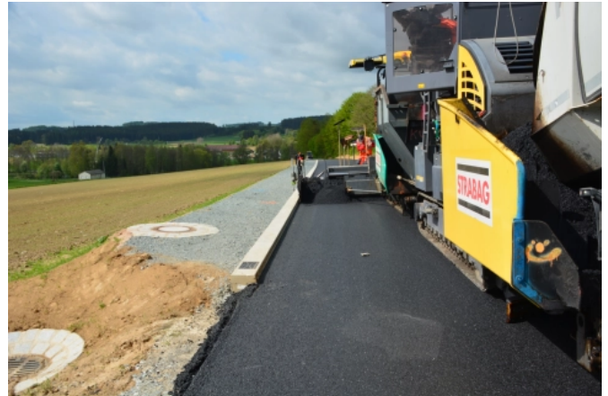
Sanierung der Staatstraße 2693 mit der Hohlbordrinne ACO DRAIN® Kerbdrain Road
