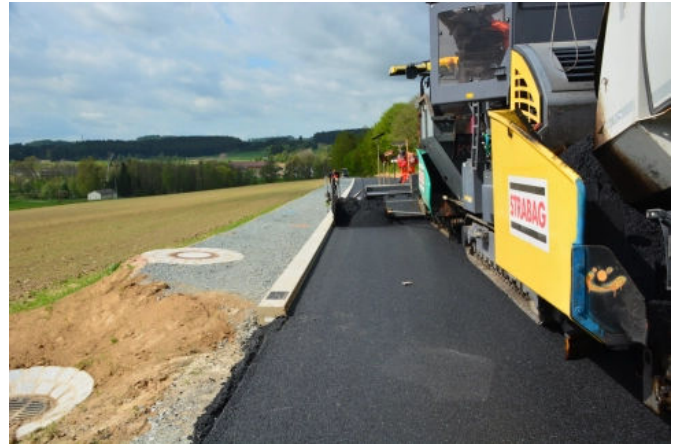
Sanierung der Staatstraße 2693 mit der Hohlbordrinne ACO DRAIN® Kerbdrain Road
