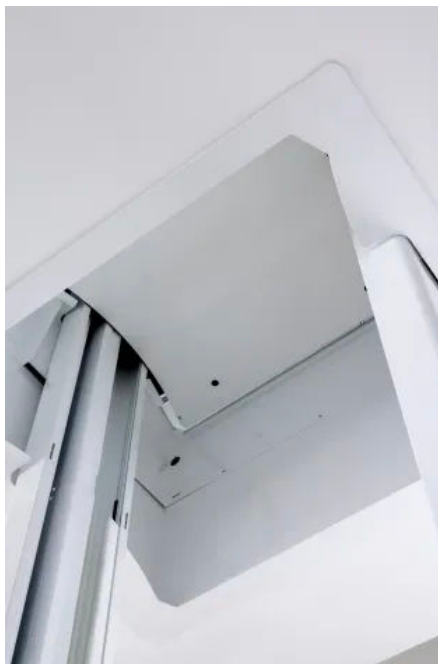
Der Luma wird direkt am Boden montiert und benötigt keine Schachtgrube; lediglich eine quadratische Deckenöffnung. (© liliana ortiz savaria)
