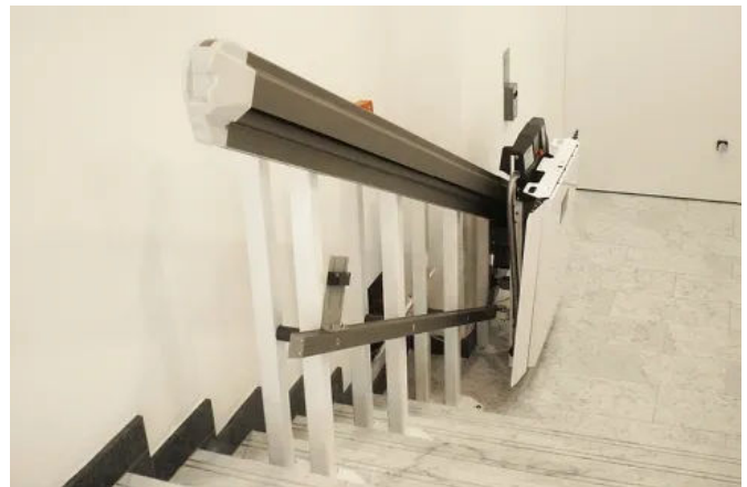
Ist keine geeignete oder tragfähige Wand vorhanden, wird der X3 auf Fahrbahnstützen installiert.
