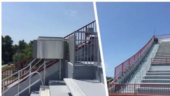
Der Plattformlift Artira Außen überwindet Treppen und Podeste barrierefrei über eine Länge von 60 Metern.
