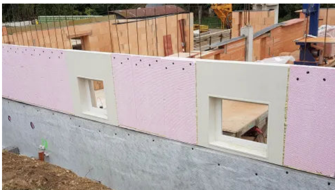
Zargenfenster, Perimeterabdeckrahmen und das GFK-Montagedämmelement bilden ein genau aufeinander abgestimmtes System.
