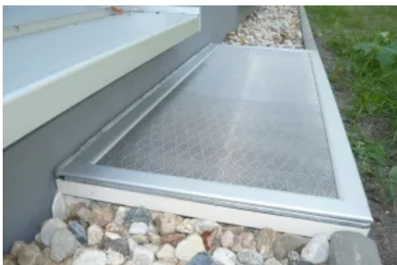
Lichtschachtabdeckung aus Edelstahlgewebe
