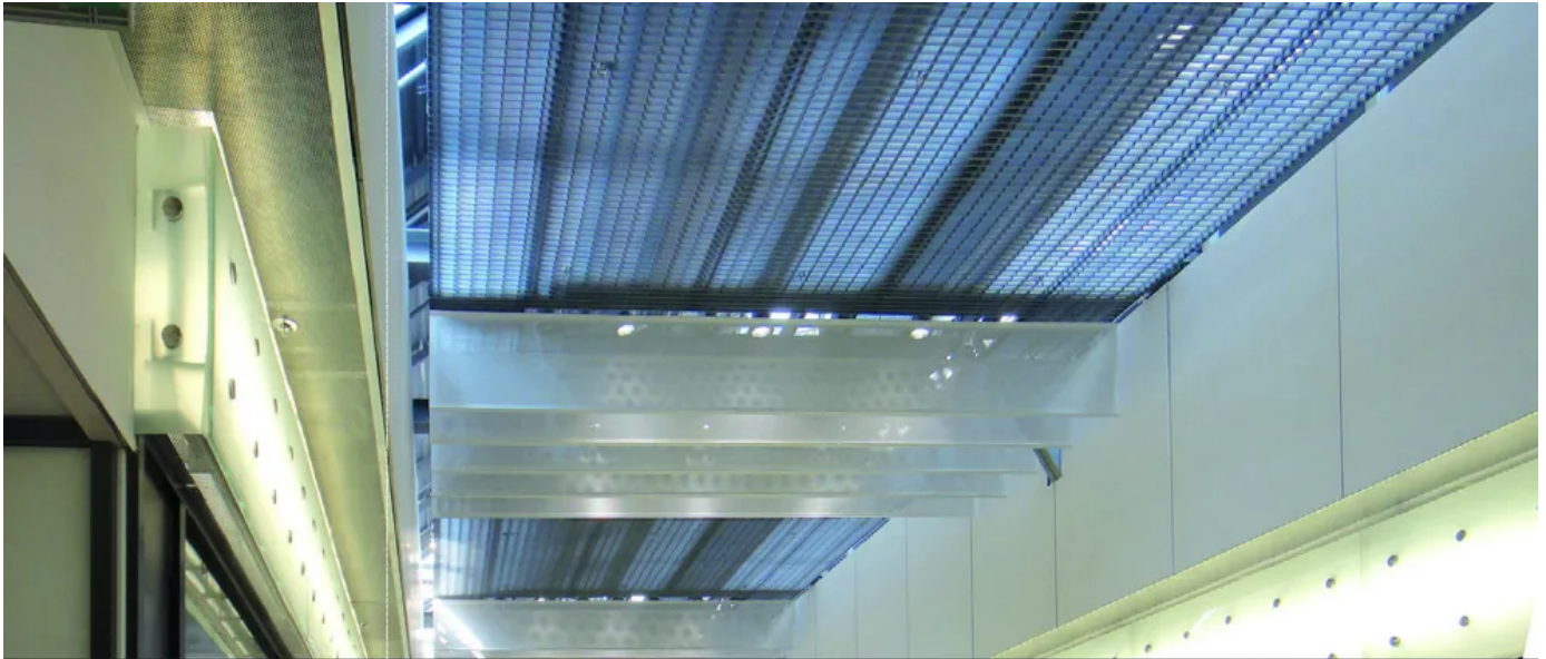
Abgehängte Lichtrasterdecke mit Aluminium-Profilen – flexible Abhängetechnik für großflächige Räume und komplexe Deckenarchitektur.
