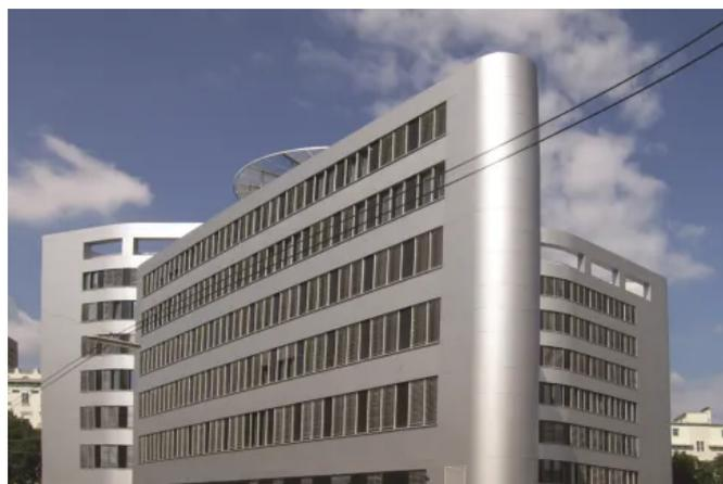
Lamellensysteme mit Spiegeloptiken verbessern den Lichteintrag. Gleichzeitig verhindert die gezielte Lichtauslenkung die Aufheizung der Fensterzone.
