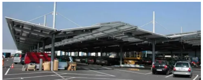
Verwendete Produkte: Rhenotop Vario First I 3 Lichtbänder, 130 Meter lang und 5 Meter breit
