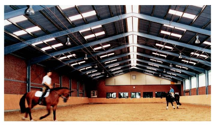
Rhenalux ist ein komplettes System zur Belichtung und gleichzeitigen Entlüftung von Stallungen und Reitanlagen.
