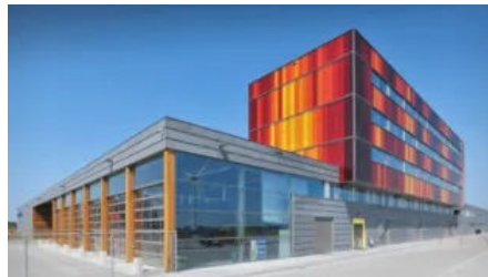
Feuerwehr Terneuzen (© Rodeca)
