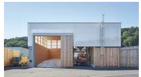
Betriebshof Stuttgart (© Achim Birnbaum)
