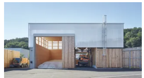
Betriebshof Stuttgart (© Achim Birnbaum)
