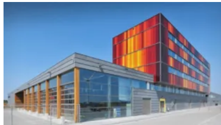
Feuerwehr Terneuzen (© Rodeca)
