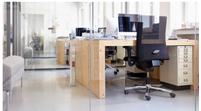
Installationssäulen Boden werden auf dem Boden montiert und von unten mit Strom versorgt.
