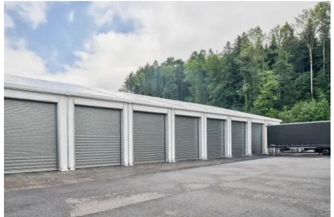
Unisolierte Leichtbauhalle
