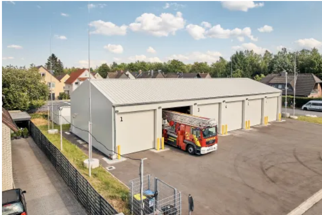
Isolierte Leichtbauhalle (© Roman Thomas)
