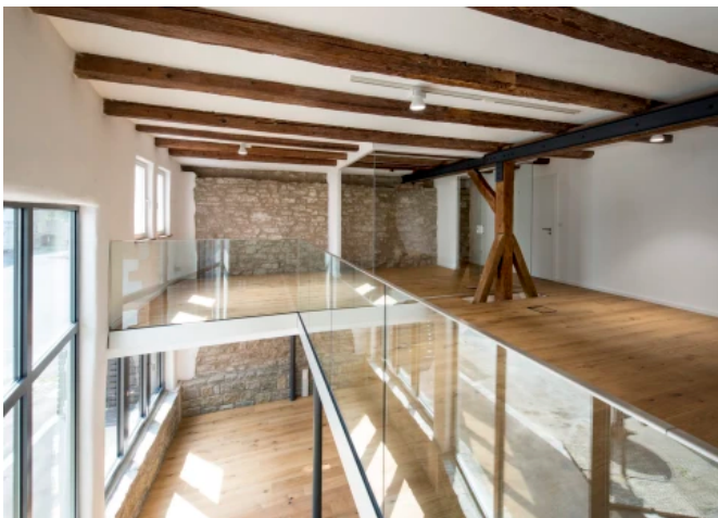
Für die Sanierung der Huchler-Scheune galt es, eine Lösung zu finden, ohne viel Eigengewicht einen Höhenausgleich von 35 cm zu schaffen. Besondere Herausforderung für die Statik. Die historische Stadtmauer ist zugleich tragende Außenwand und das gesamte Objekt lehnte daran auf.
