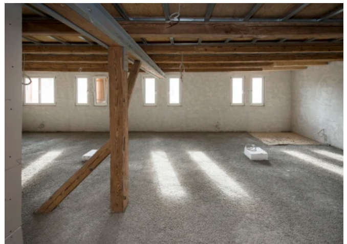
Uzin unterstützte mit dem Leichtestrich Turbolight-System den Bodenaufbau, denn gerade hier zählte der Statiker jedes Gramm Deckenbelastung nach. Weitere Pluspunkte des Systems: geringes Flächengewicht, geringe Aufbauhöhe und schnelle Trocknungszeiten mit schneller Belagreihe.
