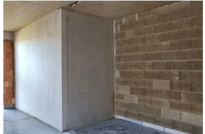
Lehmbloc®-Lehmsteine und Poroton-Ziegeln lassen sich innerhalb eines Gebäudes kombinieren.
