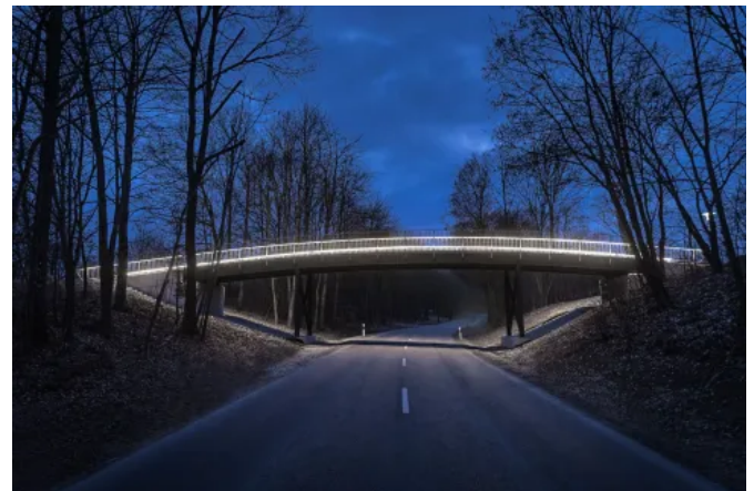
Handlaufsystem LUX GLENDER SAFE - Fußgängerbrücke Nördlingen | Minimiert die Blendung des darunterliegenden Straßenverkehrs. Ausführung: Profil LILLY asymmetrisch, IP65
