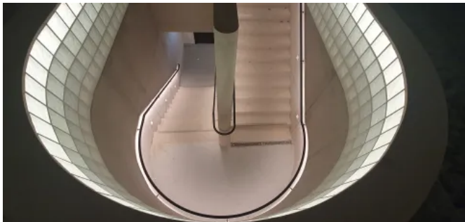
Handlaufsystem LUX GLENDER BASIC gebogen - Kreissparkasse Weil am Rhein | Auf die moderne Architektur abgestimmtes Handlaufsystem. Ausführung: Lichtaustritt symmetrisch, IP20 und IP65
