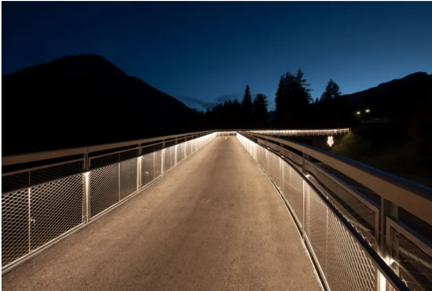
LUX GLENDER SAFE - Brücke St. Anton am Arlberg | Ausführung: Lichtaustritt asymmetrisch, 3D gewendelter Handlauf LILLY, IP65
