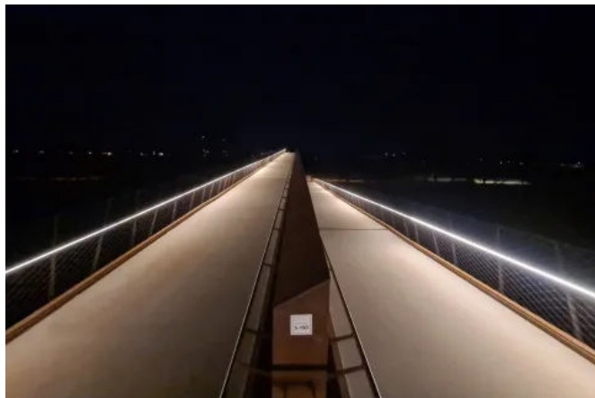
Handlaufsystem LUX GLENDER SAFE - Fußgängerbrücke Buga 2023 in Mannheim | Einseitige symmetrische Beleuchtung der Laufbahn. Ausführung IP65, um ca. 15° gedrehter Handlauf LILLY.
