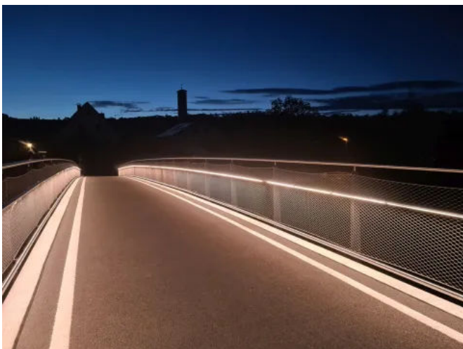
LUX GLENDER ULTRA SAFE - Fuß- und Radwegbrücke Herbolzheim | Ausführung: Handlaufprofil NINA, um 15° gedreht, IP69
