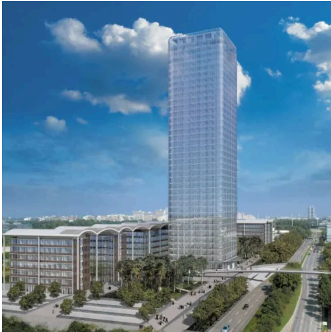
Uptown Büroturm München | Individuelle Steuerung mit LCN
