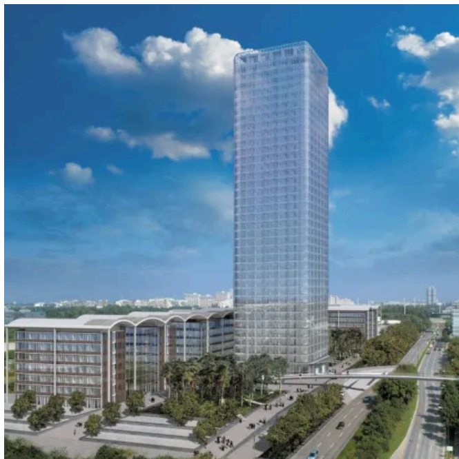
Uptown Büroturm München | Individuelle Steuerung mit LCN
