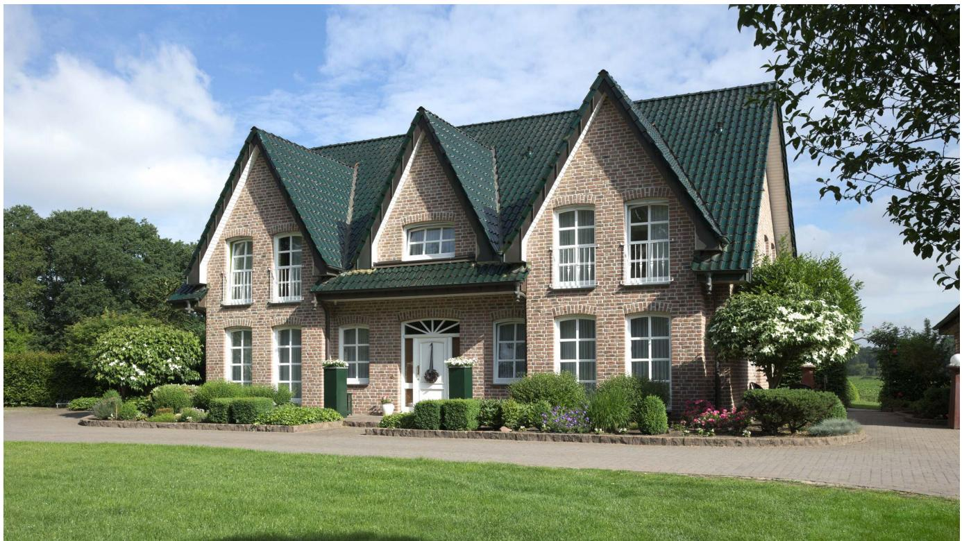
Die doppelten Kopf- und Seitenverfalzungen machen die Hohlfalzziegel IDEAL unempfindlich gegen Treibregen und Flugschneeeintrieb.
