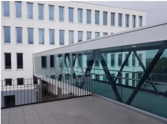
Brücke, Grammer, Ursensollen
