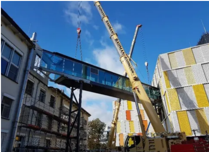
Verbindungsbrücke, ELKI Uni-Klinikum, Bonn
