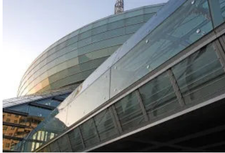
S9 – Havenbrücke Bremerhaven, Foto: Lenderoth Metallbau
