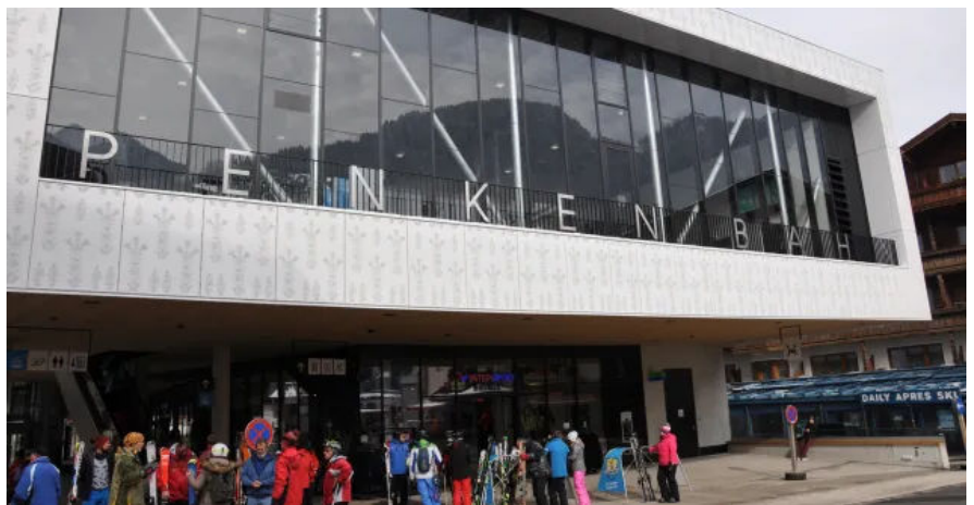
S9-45° - Penkenbahn Talstation, Foto: Mayrhofer Bergbahnen
