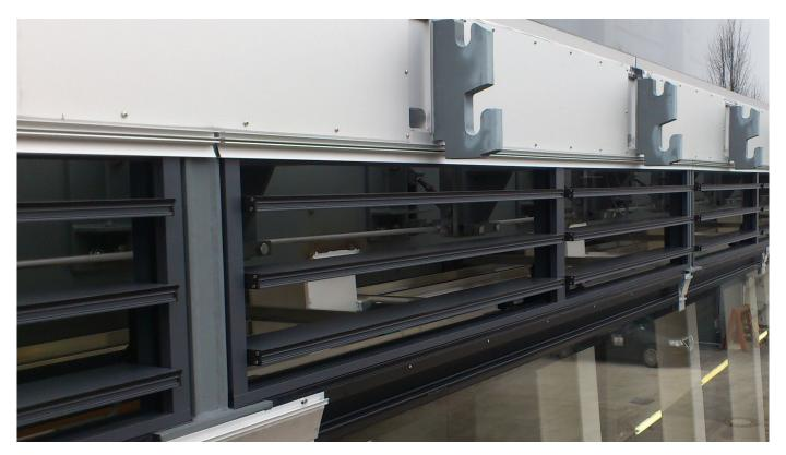
FLL (FIEGER Lamellenfenster mit Lüftungslamellen), für natürliche Lüftung, natürlichen Rauch- und Wärmeabzug (NRWG) und Aufzugsschachtentrauchung
