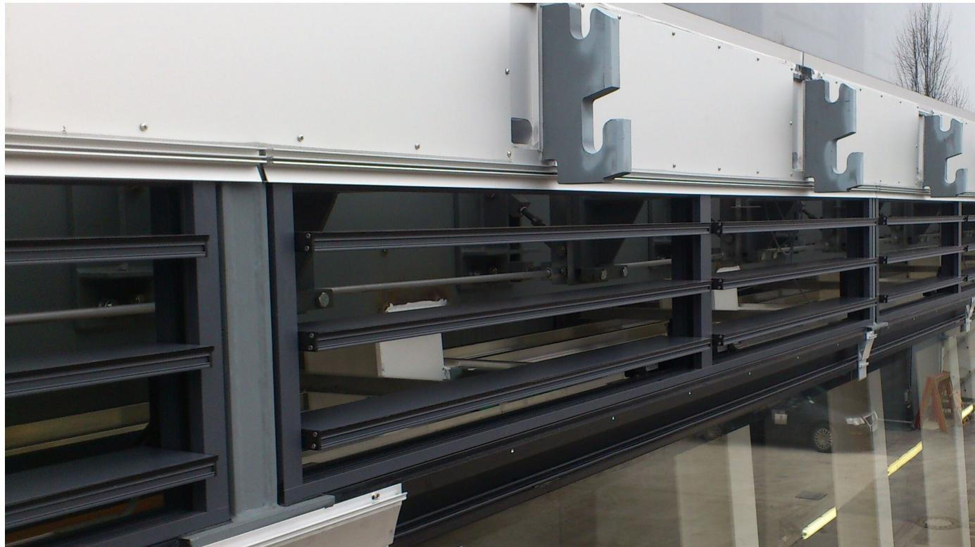
FLL (FIEGER Lamellenfenster mit Lüftungslamellen), für natürliche Lüftung, natürlichen Rauch- und Wärmeabzug (NRWG) und Aufzugsschachtrauchung
