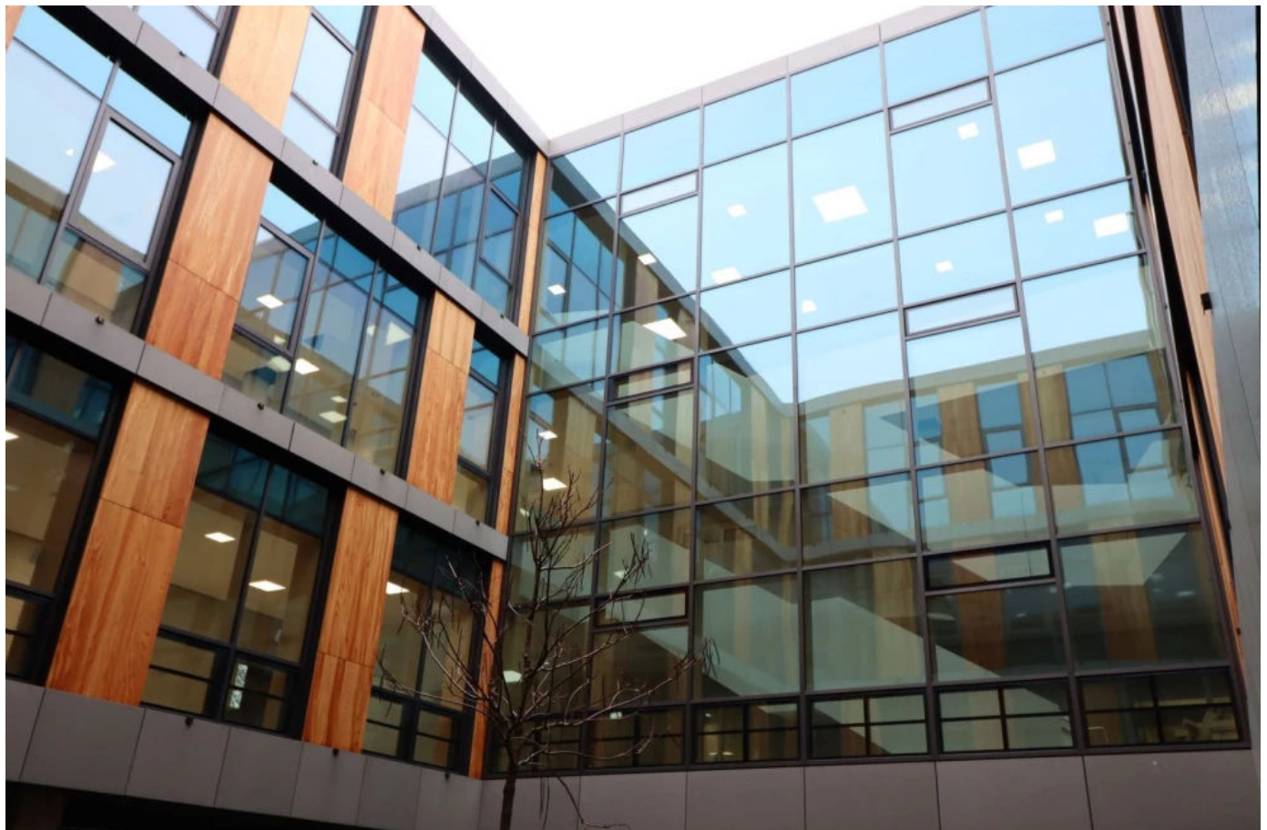
Objektbeispiel Lamellenfenster bigAir® Fassade, Wissenschaftszentrum am Campus Straubing
