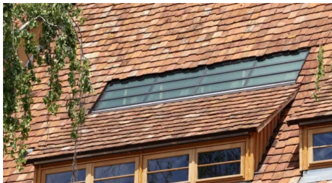
3-Fach-Sonnenschutzverglasung und Insektenschutzgitter ©LACKER GmbH
