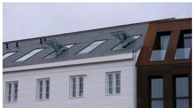
Objektbeispiel: 2-teilige topSwing Fenster, die flächenbündig in ein Schieferdach eingebaut wurden. Nutzung auch als Ausstiegfenster möglich.
