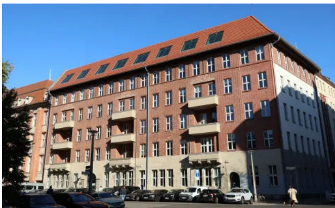
Für den Umbau des Dachbereichs des denkmalgeschützten Gebäudes wurde auf die Dachfenster der Serie bigAir® von Lackner gesetzt © LACKER GmbH
