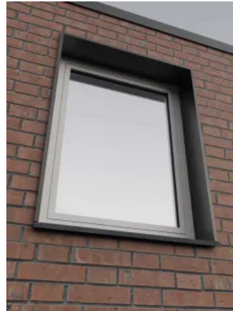
Stein- und Ziegelfassade
