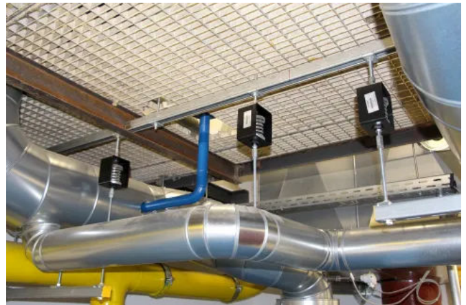
Entkopplung von Rohre mit Isotop SD Z
