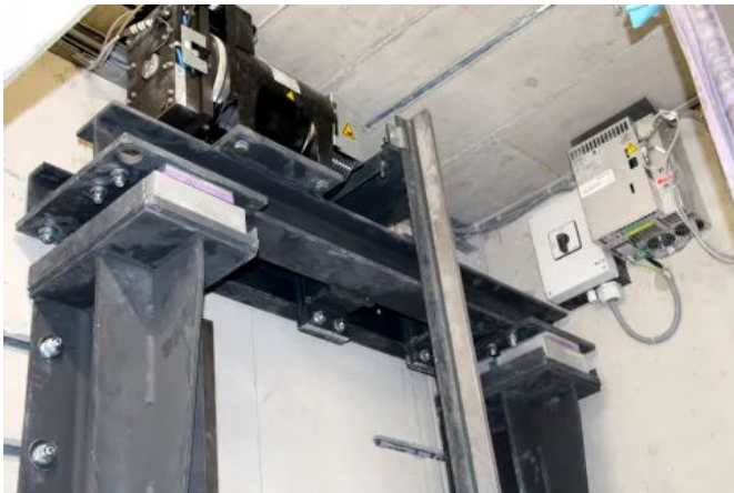
Lagerung einer Aufzuganlage mit Isotop SE-DE
