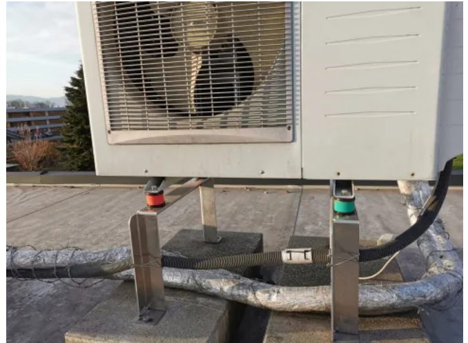
Lagerung einer Wärmepumpe mit MSN-DAMP
