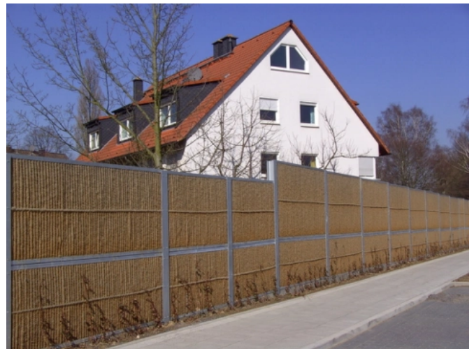
Lärmschutz in Essen
