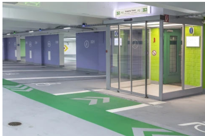
Freiburgs Parkhaus „Karlsbau“, Freiburg - Planung: Caparol / Dipl.-Des. Petra Ruhnau | Foto: Caparol / Martin Dückek
