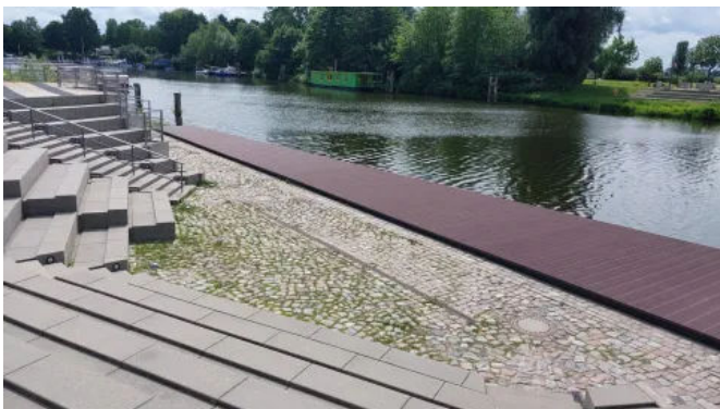
Sanierung der 180 m 2 großen Seebühne in Geesthacht mit langlebigen TRIMAX® Kunststoff-Bohlen 5 x 30 cm in Dunkelbraun
