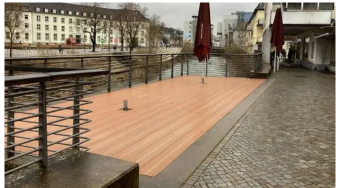
Sanierung neuer Gastroterrassen in Siegen mit TRIMAX® Dielen aus Kunststoff mit geriffelter Oberfläche im Farbton Hellbraun
