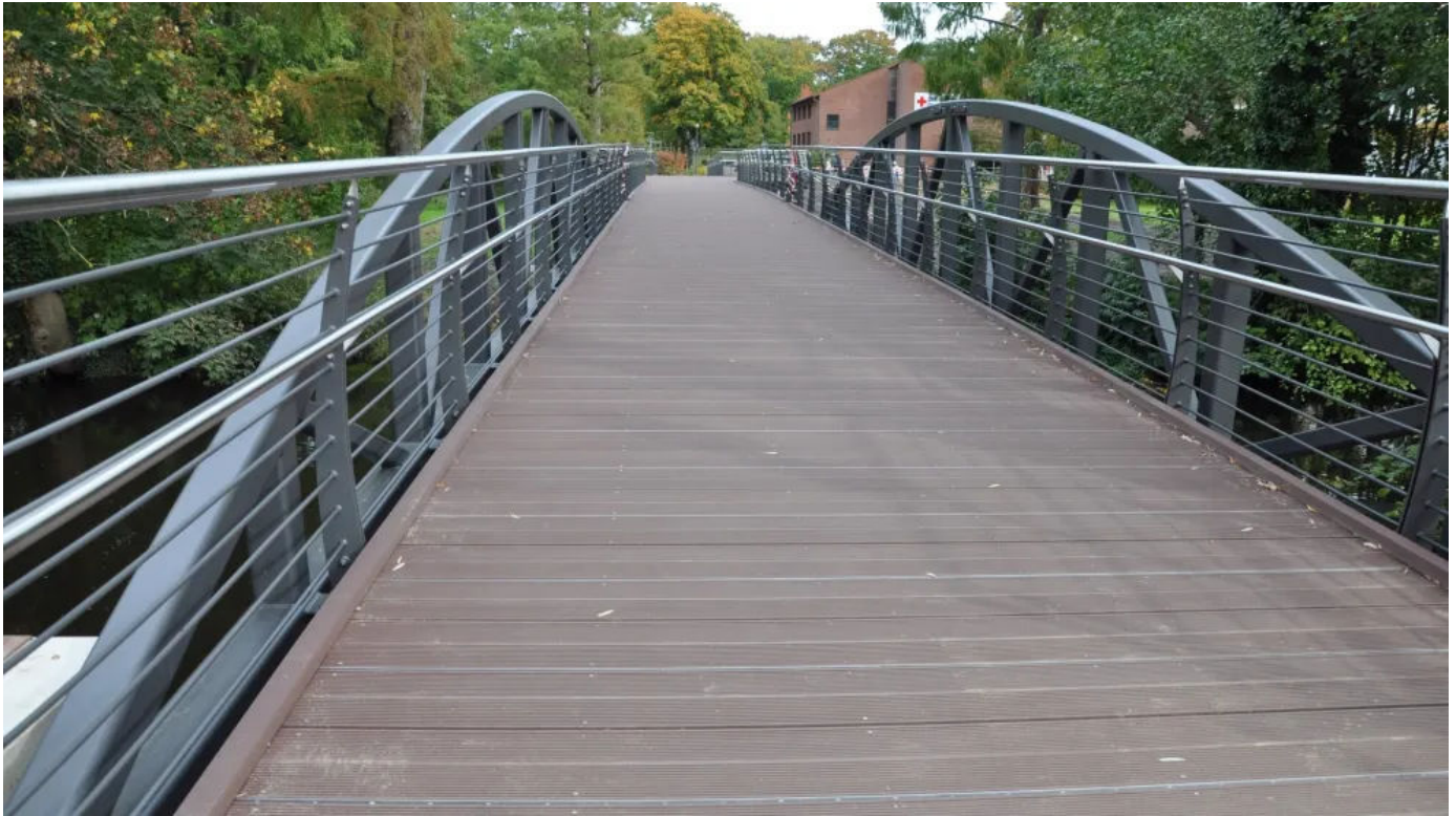
Neubau der Langen Brücke in Uelzen mit Belag aus 5 cm dicken TRIMAX® Riffelbohlen aus Kunststoff mit einer Breite von 30 cm
