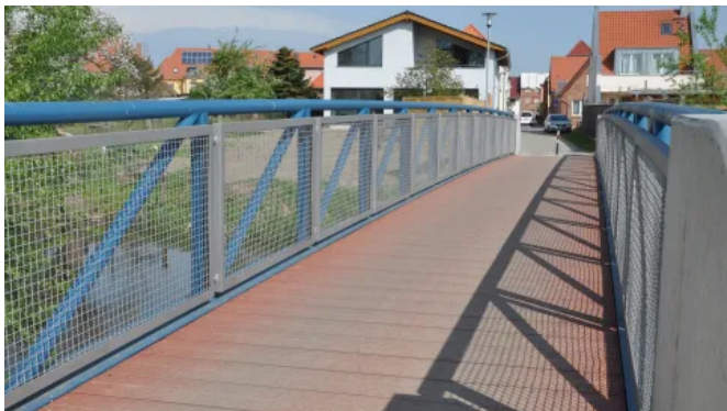
Sanierung der Elefantenbrücke in Bützow mit den bauaufsichtlich zugelassenen Profilen TRIMAX®
