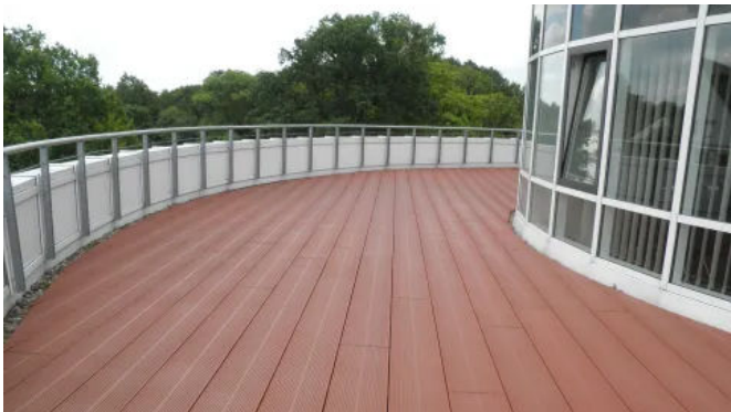
Sanierung der Dachterrasse am Rathaus in Uelzen mit TRIMAX®-Riffelbohle in rotbraun
