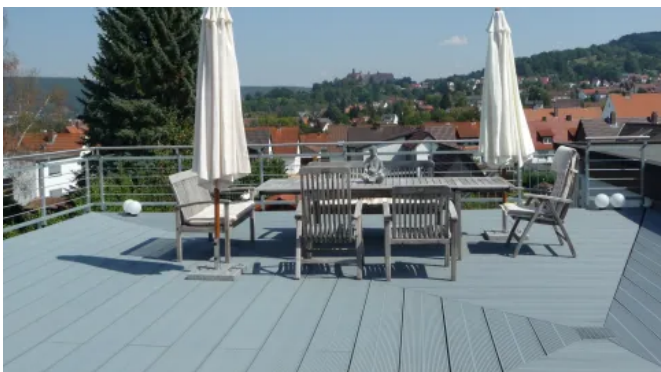
Sanierte Dachterrasse in Kulmbach mit TRIMAX® Terrassendielen 3 x 30 cm aus Kunststoff im Farbton Grau
