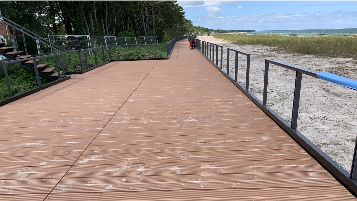
Verrottungsbeständiges, glasfaserverstärktes Kunststoffbaumaterial mit allgemeiner bauaufsichtlicher Zulassung
