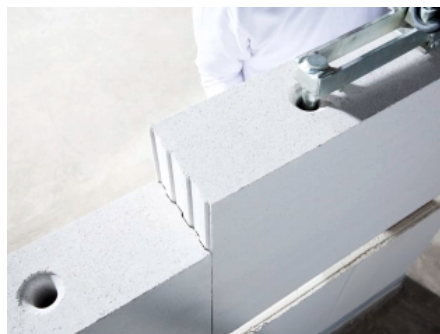
Mauern von KS-PLUS in Dünnbettmörtel, Stoßfugen unvermörtelt
