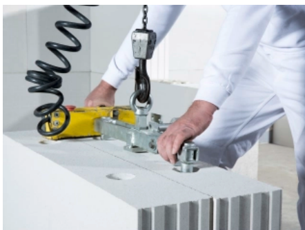
Versetzen der KS-PLUS Planelemente mit dem Versetzgerät
