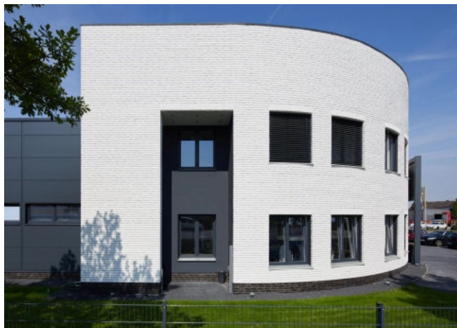
Wäscherei Markus in Lohne (Bild: Csaba Mester / KS-ORIGINAL GMBH)
