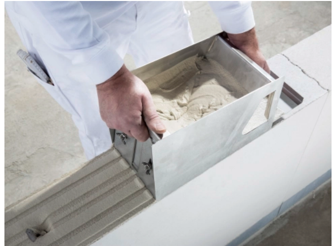
KS Plansteine werden mit Dünnbettmörtel "verklebt".
