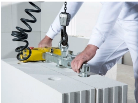
Versetzen der KS-PLUS Planelemente mit dem Versetzgerät
