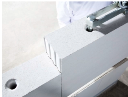
Mauern von KS-PLUS in Dünnbettmörtel, Stoßfugen unvermörtelt
