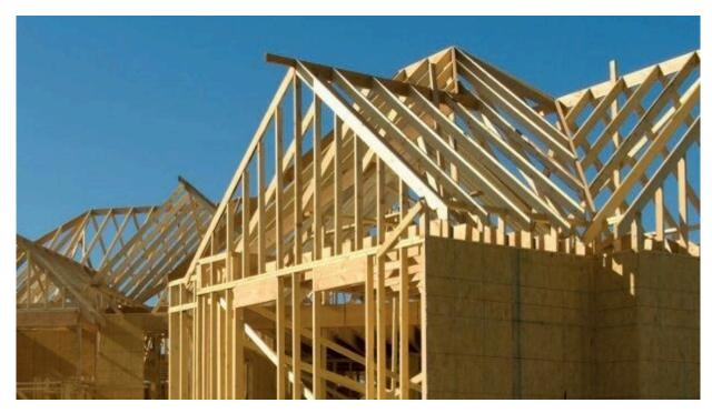
Kronobuild OSB Next Generation ist eine "high-tech" Holzwerkstoffplatte aus harzgebundenen Holzstrands, die vorrangig aus Recyclingholz hergestellt wird. Die kreuzweise Anordnung der langen Holzstrands in Lagen verleiht der Platte gute technische Eigenschaften.
