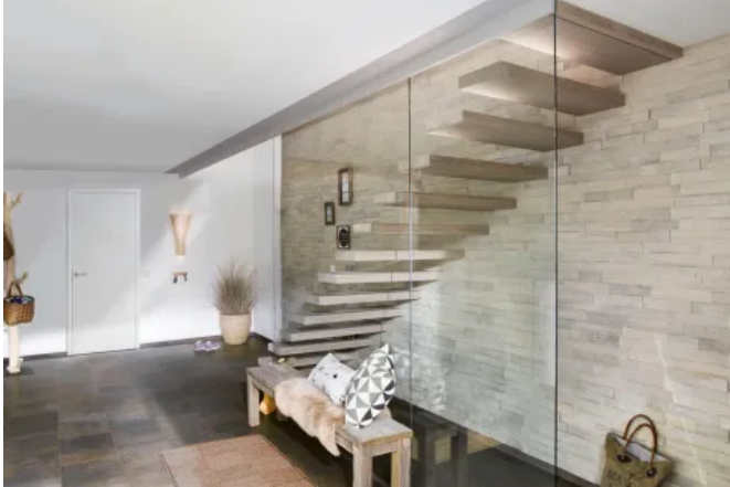
Kragarmtreppe mit Kragstufen aus Holz und Glaswand 686w
