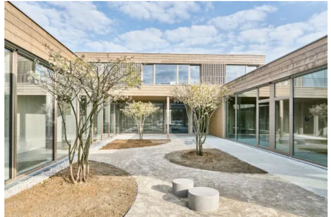
Konstruktiver Holzbau (© Eder Holzbau GmbH, Bad Feilnbach)
