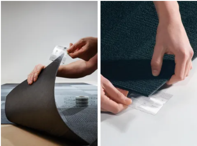
Verlegung mit TacTiles®
