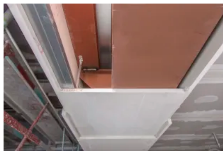
Abgehängte Plattendecke F90 mit Fireboard Beplankung unter Massivdecke mit freiliegenden Stahlträgern.
