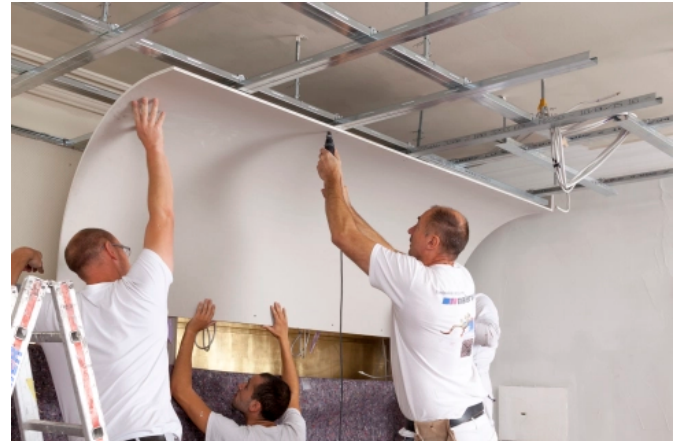
Für Decken-Designlösungen können die gebogenen Formteile fix und fertig geliefert werden.
