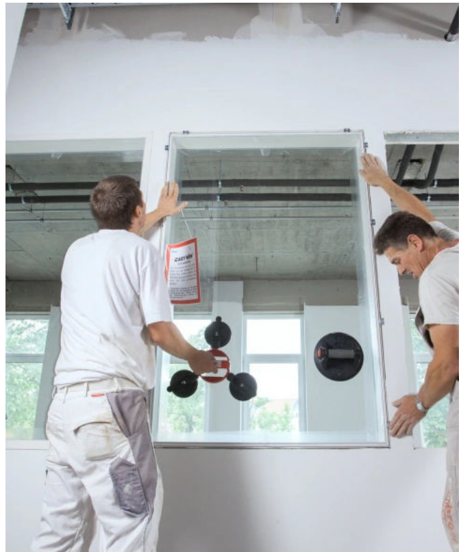
Die EasyWin Fertigfenster werden montagefertig als Monoblock mit wandbündiger Doppelverglasung auf die Baustelle geliefert.
