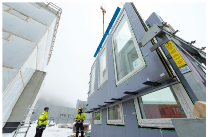
Knauf Stahl-Leichtbau-Profile können als Bauelemente oder ganze Raumzellen verbunden werden. So entstehen Baumodule für Schulen, das Gesundheitswesen oder den Hausbau.
