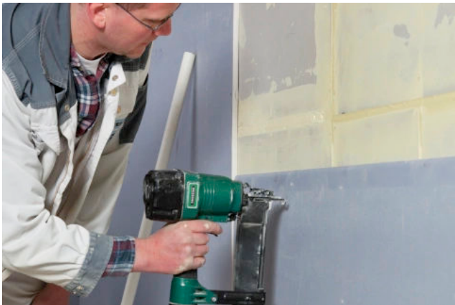
Keine Fugen hinterlegung mit Blei – statt dessen kommt nur Knauf Safeboardspachtel zum Einsatz.
