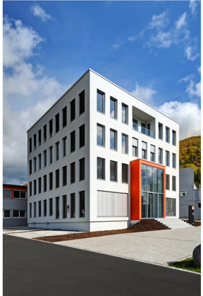
Knauf Stahl-Leichtbau-Fassade, Kubus AMF, Grafenau
