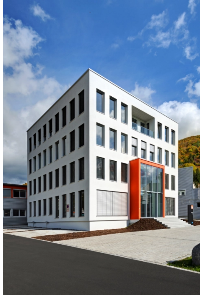
Knauf Stahl-Leichtbau-Fassade, Kubus AMF, Grafenau
