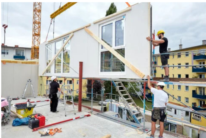
Holzbau mit Knauf
