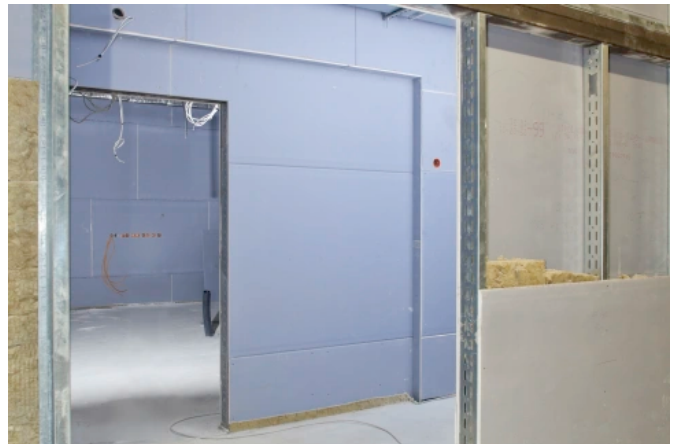
Für Schutz vor Beschädigungen und die perfekte Oberfläche sorgt eine Decklage Knauf Diamant.
