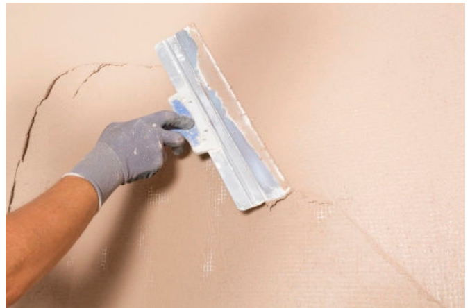
Der Rotkalk Oberputz wird mit Traufel oder Glättkelle eben verzogen.
