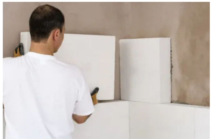
Die Dämmplatten Rotkalk in-Board TecTem werden vollflächig verklebt - eine Dampfsperre ist nicht nötig.
