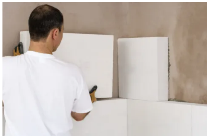
Die Dämmplatten Rotkalk in-Board TecTem werden vollflächig verklebt - eine Dampfsperre ist nicht nötig.
