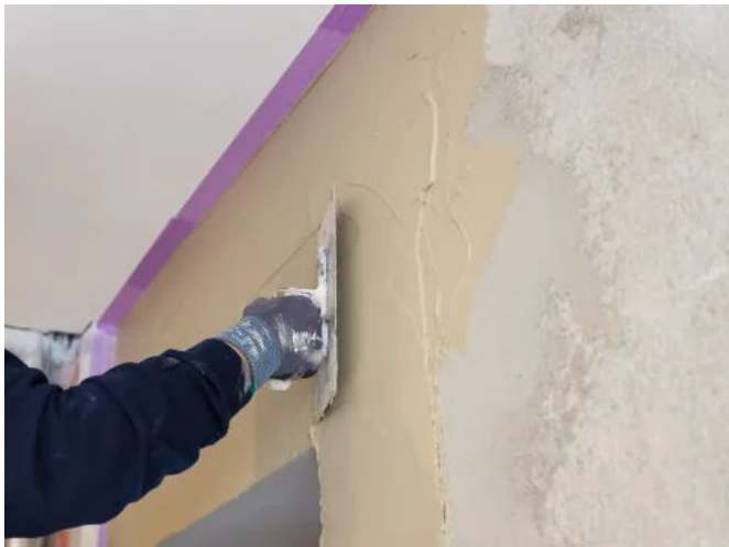
Von der Untergrundvorbereitung zur fertig verputzen Wand an einem Tag: Knauf Universal-Feinspachtel Sprint (© Knauf Presse)
