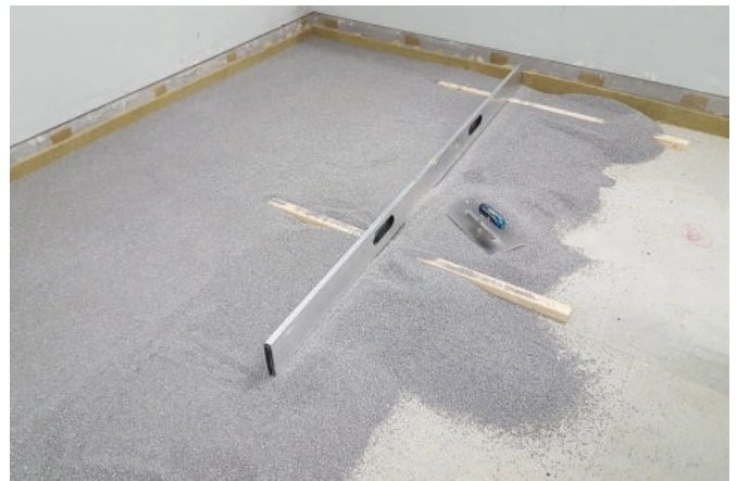
Knauf Schwere Schüttung verkrallt sich ineinander, so dass diese hoch belastbar ist.
