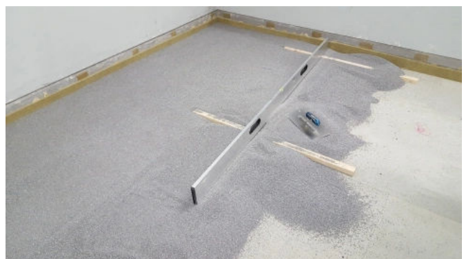
Knauf Schwere Schüttung verbessert den Schallschutz von Holzbalkendecken und dient als Rohbodenausgleich unter Estrichen.
