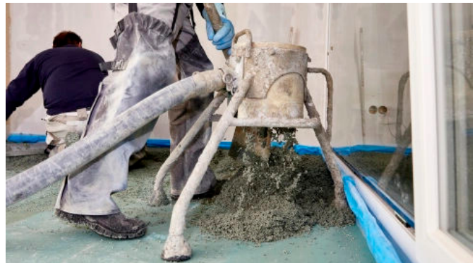
S 400 Sprint ist ein schnelltrocknender Leichtausgleichmörtel aus EPS Zuschlag und zementärem Spezialbinder.
