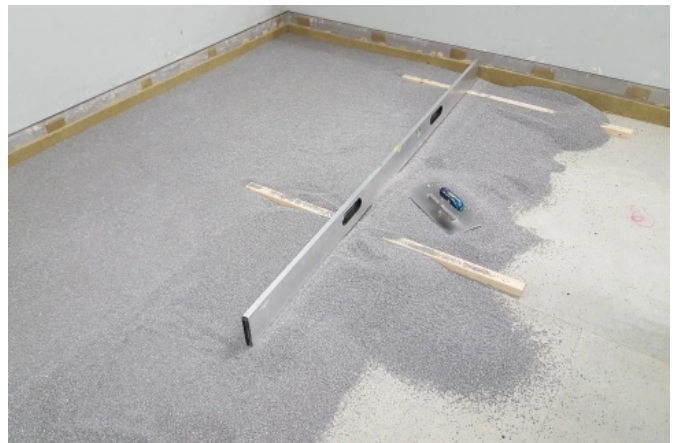
Knauf Schwere Schüttung verkrallt sich ineinander, so dass diese hoch belastbar ist.
