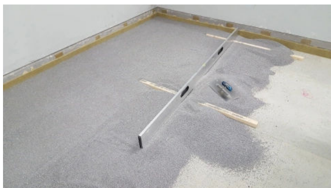
Knauf Schwere Schüttung verbessert den Schallschutz von Holzbalkendecken und dient als Rohbodenausgleich unter Estrichen.
