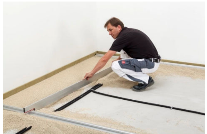
Auf Trockenschüttung PA lassen sich alle Knauf Fertigteil- oder Fließestriche verlegen.
