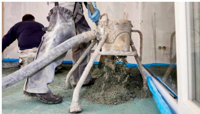
S 400 Sprint ist ein schnelltrocknender Leichtausgleichmörtel aus EPS Zuschlag und zementärem Spezialbinder.
