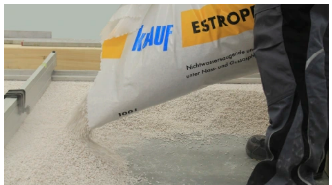
Ausgleichsschüttungen aus geblähtem Vulkangestein Perlit können zum Höhenausgleich und zur Wärmedämmung unter Nass- und Gussasphaltestrichen eingesetzt werden.
