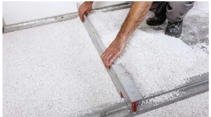
Trockenschüttungen aus Perlite können als Ausgleichs- und Dämmschicht für Schütthöhen bis 200 mm eingesetzt werden.
